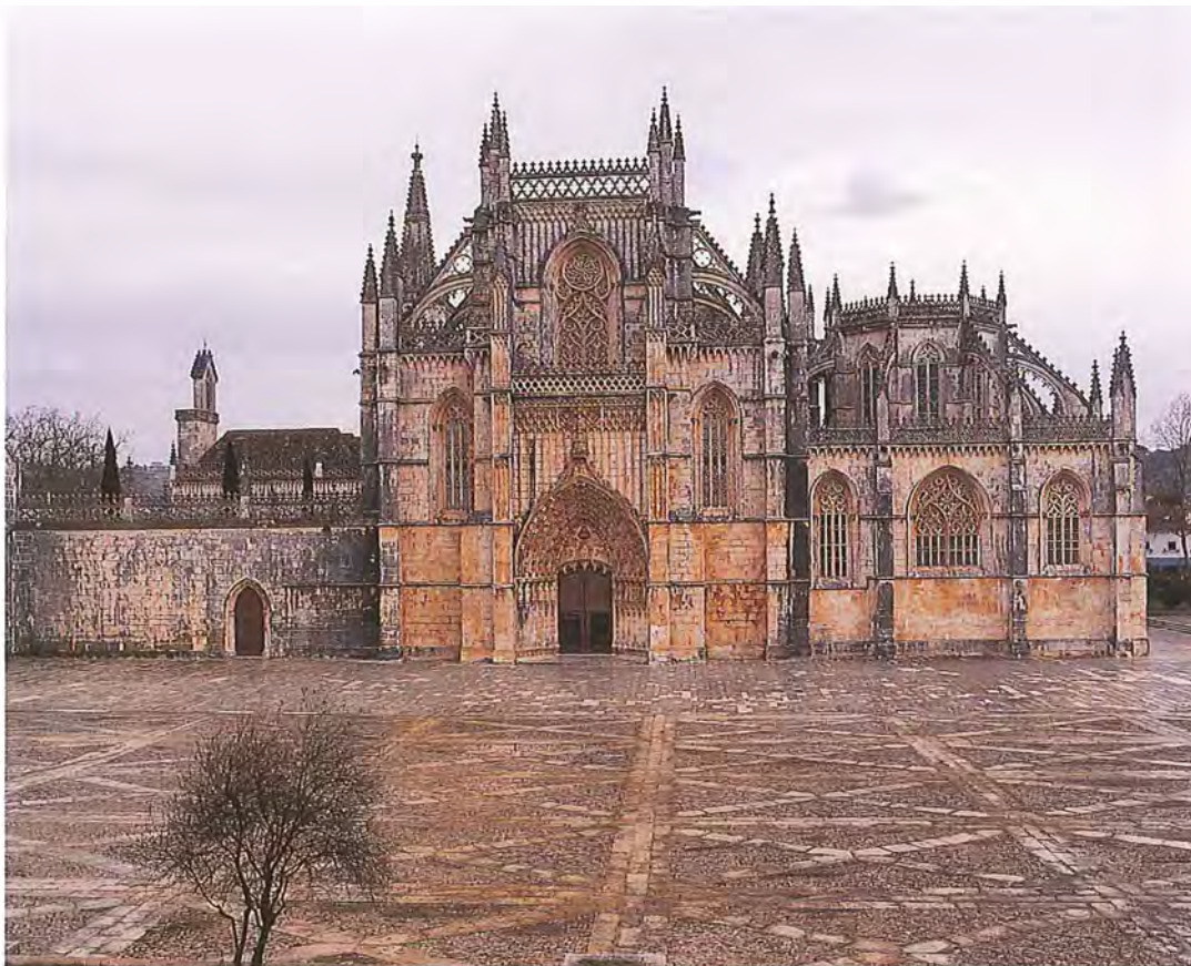
Fachada do mosteiro da Batalha. Fotografia de Laura Castro Caldas e Paulo Cintra.
